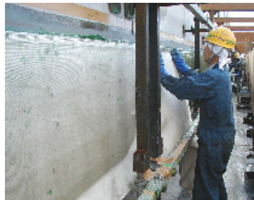
繊維シート貼付工（横桁端部）
