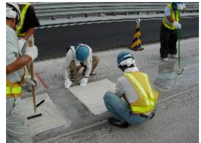
繊維シート貼付工（床版上面部）
