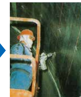
②穿孔工・孔内清掃
