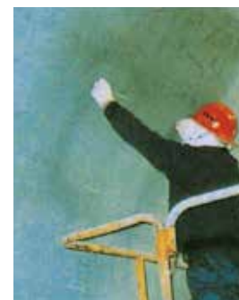
①マーキング工
