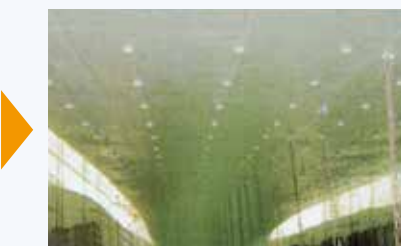
▲床版下面＜施工後＞
