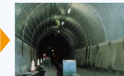
▲トンネル＜施工後＞
