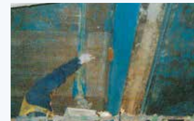
▲トールゲートのはく落防止工事
