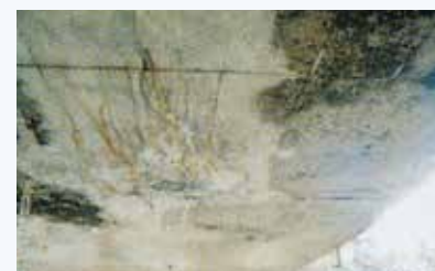
▲床版下面＜施工前＞
