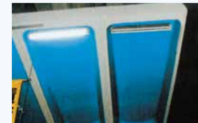
▲トールゲート屋根裏（天井）部分
