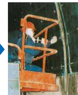
③アンカー工
