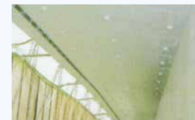
▲床版張り出し部分＜施工後＞
