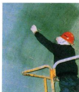
① マーキング工
