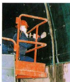
③ アンカー工
