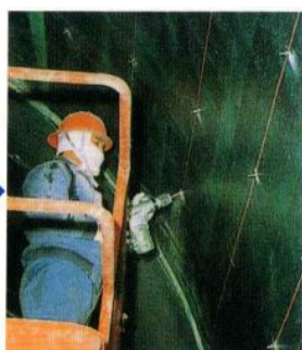
② 穿孔工・孔内清掃
